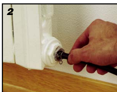
2 Avvitare il tubetto di scarico in dotazione
