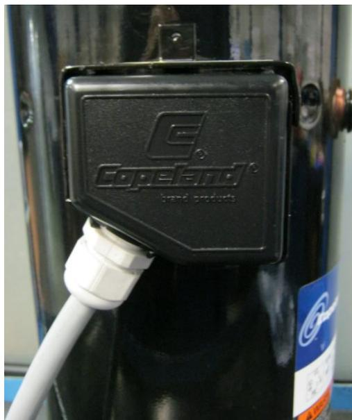
Figura 14: Corretta installazione elettrica con pressacavi per scatola elettrica IP21 (modelli da ZB15K\* a ZB45K\*)
