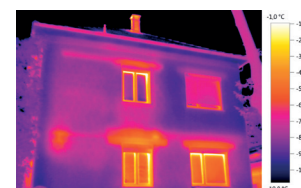
Immagine termografica con ScaleAssist
