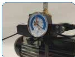
Collegamento con pompa per vuoto
