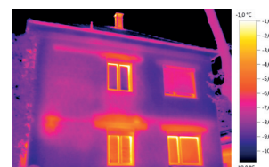
Immagine termografica con ScaleAssist
